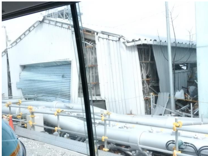
写真5. 凍土壁をつくる液体を送り込むパイプライン
